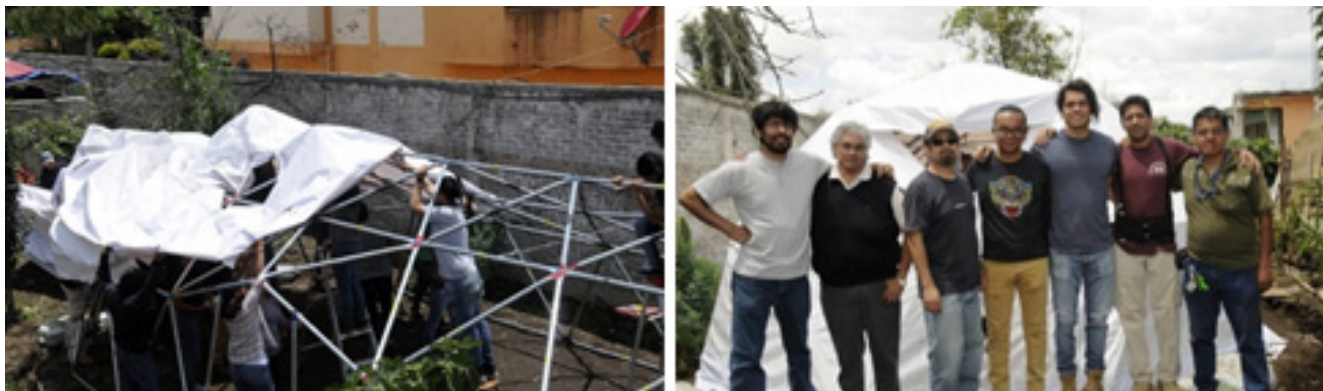
Tras los sismos ocurridos en septiembre de 2017, el área de investigación “Tecnología e Informática para el Diseño” fabricó y entregó una Estructura Geodésica en San Luis Tlaxialtemalco, Xochimilco. Foto: Facebook Cauce en línea. Boletín informativo UAM X. 2 de agosto de 2018.
